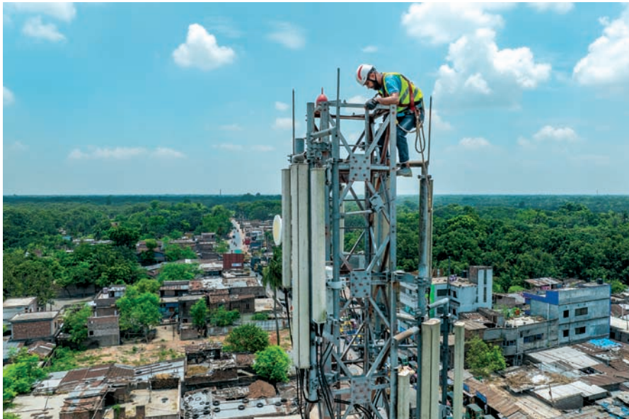
Die ADB-Gelder modernisieren Strom- und digitale Netze und schaffen so die Voraussetzung für zukünftige Industriediversifizierung
